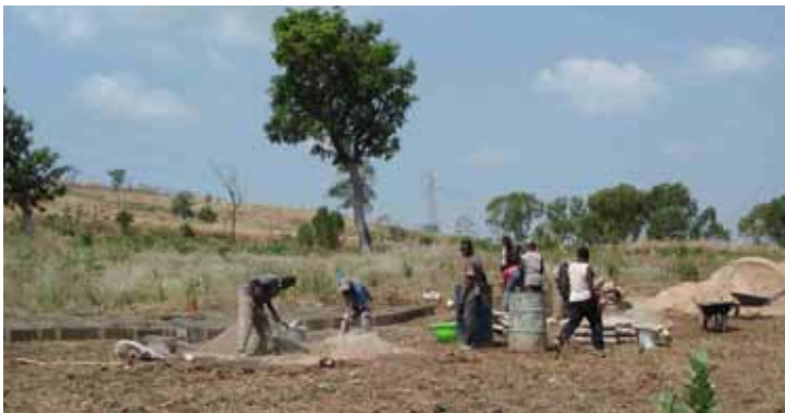
In Agbonou, einem Vorort von Atakpamé, beginnen nach der Grundsteinlegung die Bauarbeiten für die Klinik.
