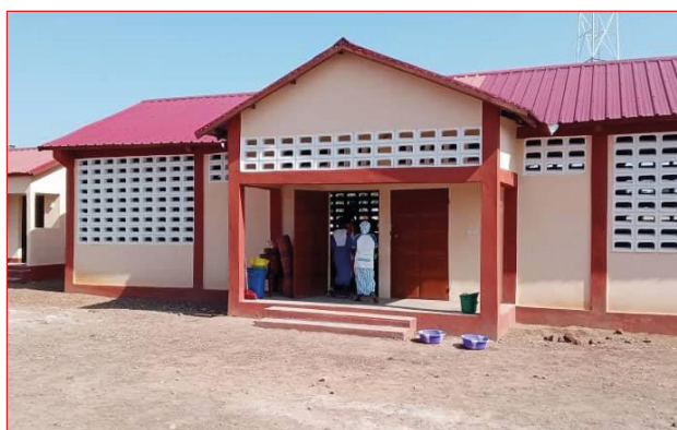
Trotz Corona wurden die Gebäude zügig fertiggestellt.
