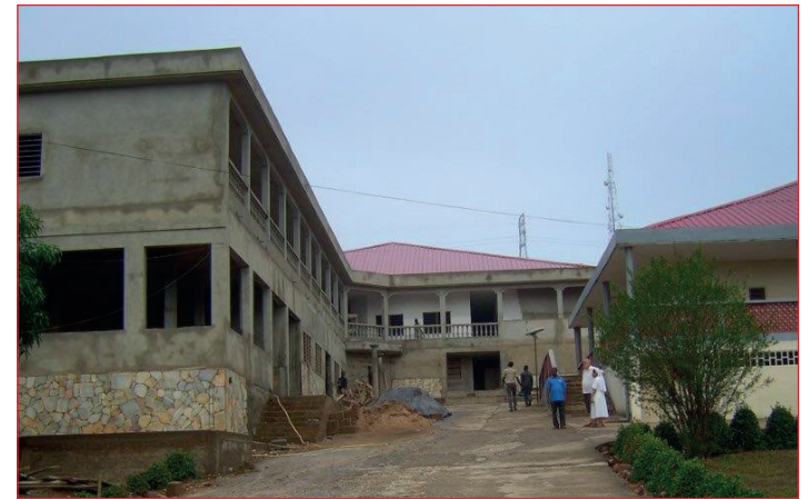
Der Neubau ist voll im Zeitrahmen: Die neue Mutter-Kind-Klinik in Atakpamé wird im Frühsommer 2015 fertig sein.
