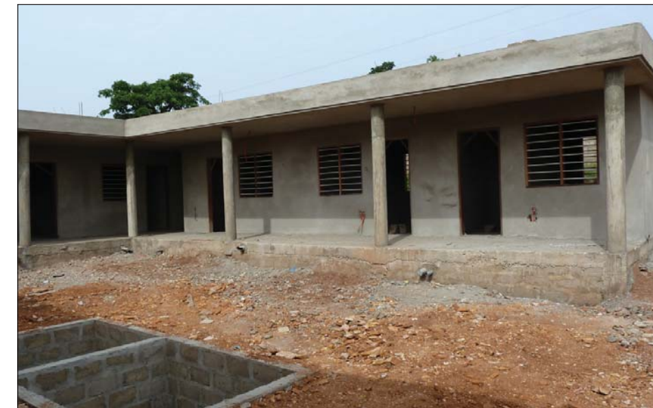
Das neue Schwesternwohnheim auf dem Gelände der Krankenstation in Atakpamé wurde in diesen Tagen fertiggestellt. Auf dem Foto ist es noch im Bau.
